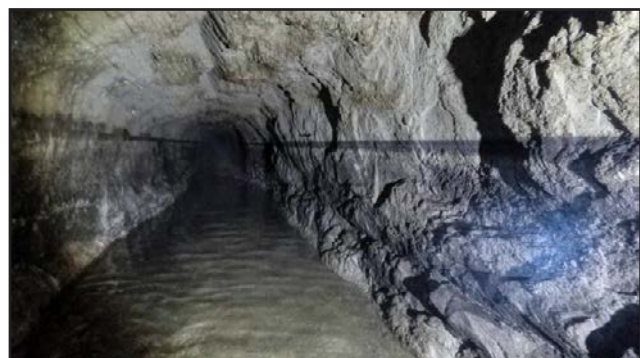
Alte Strecke mit Wasserstandsmarke.
