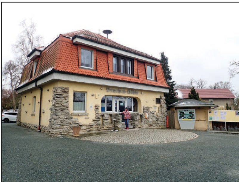
Eingangsgebäude Syrauer Drachenhöhle.
