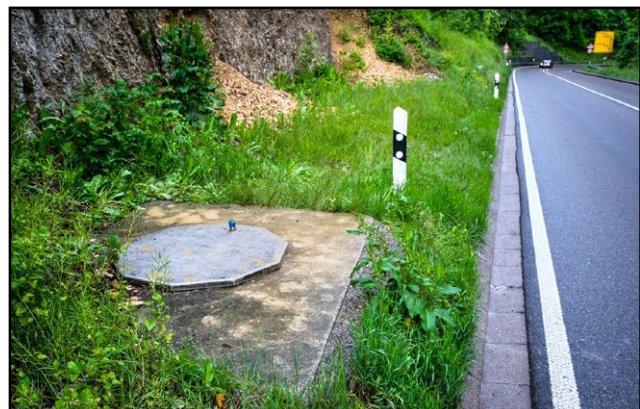
Deckel des Zugangsschachtes zur Blautopfhöhle an der B 28.
